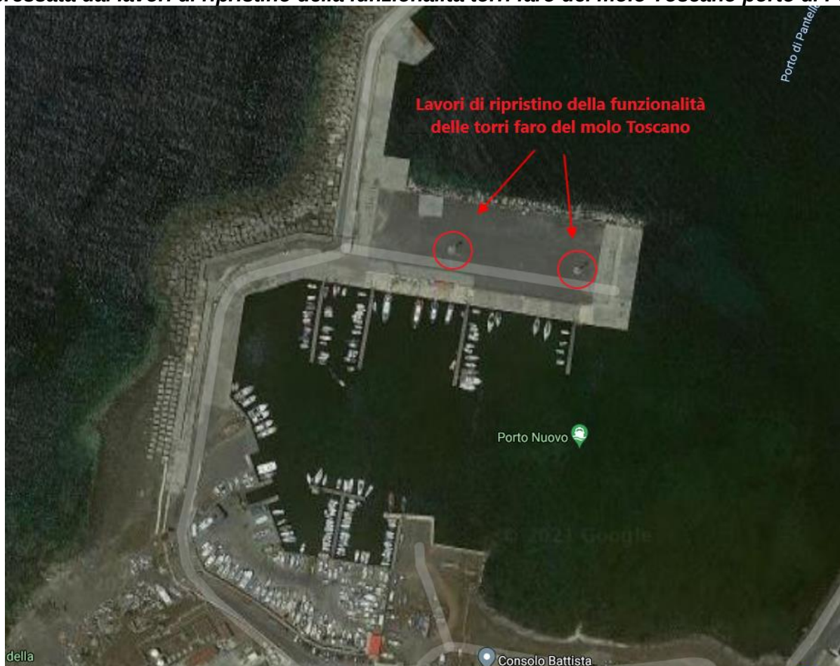
Area interessata dai lavori di ripristino della funzionalità torri faro del molo Toscano porto di Pantelleria
